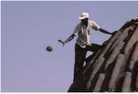
Construction d'une case musgum ©Psf
